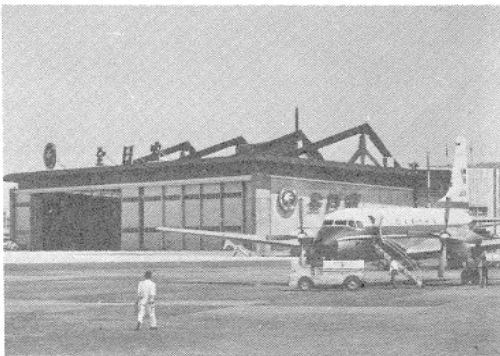
写真 1-(iv) 全日空格納庫：構造材としての高強度性質の利用と大型構造物として、又特殊な建物としての外観上の美しさ、コルテン鋼特有の茶褐色が航空機の銀色と美しくマッチしている。
