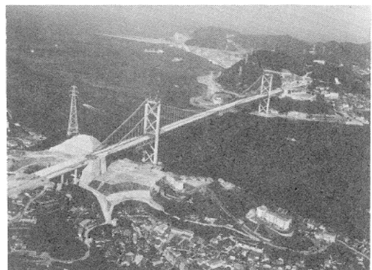
写真3-vi) 関門大橋：東洋一の大型つり橋が本州と九州を結ぶ経済の大動脈として完成されている。これらの橋梁にも新しい鋼材の利用法が見い出される。
