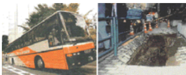
図-1 道路の陥没事例 1)
