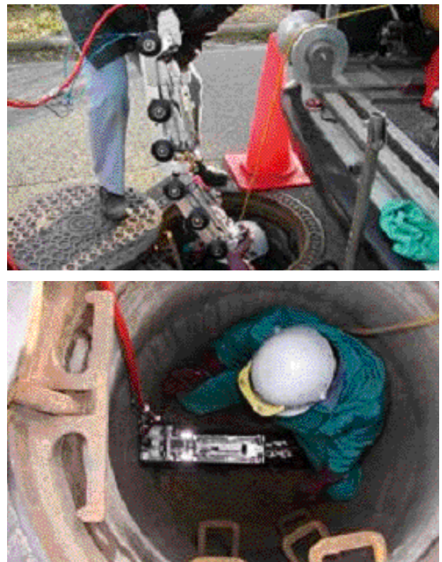
図-12 ロボット設置状況
