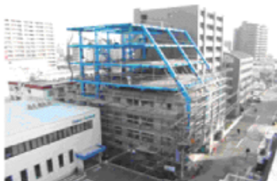
1 ミラクル構法による集合住宅の増築, 4階建→7階
