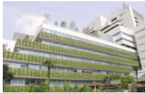
写真3 プランターネット方式施工事例：二番町ガーデン(第4回屋上・壁面・特殊緑化技術コンクール国土交通大臣賞受賞)
