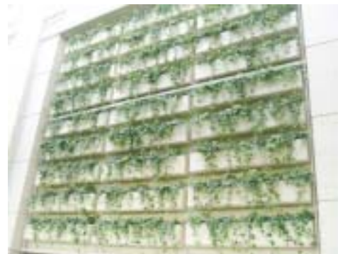
写真4 プランター設置型方式施工事例：事務所ビル外壁
