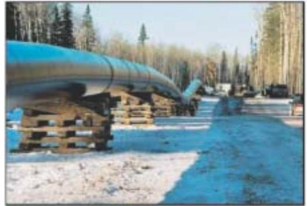
図8 X120ラインパイプのデモンストレーションライン<sup>14)</sup>
