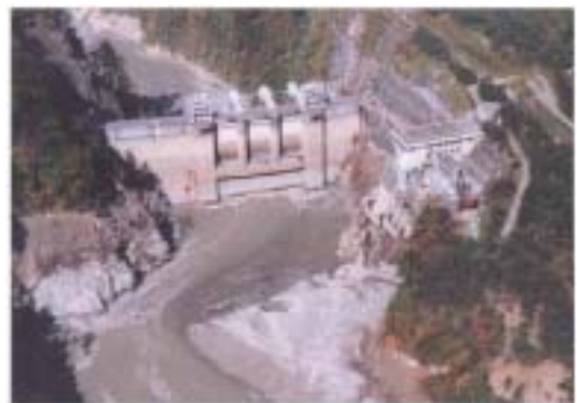
図8 排砂中の出し平ダムの状況（上流域より望む）
