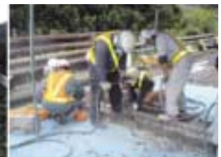
伸縮装置取替工事
