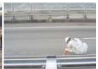
クラック補修中
