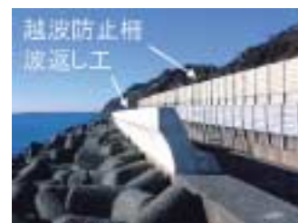
実施済み対策工
