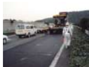
舗装補修工事
