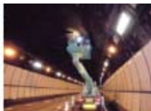
トンネル点検
