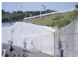
土砂等堆積状況点検
