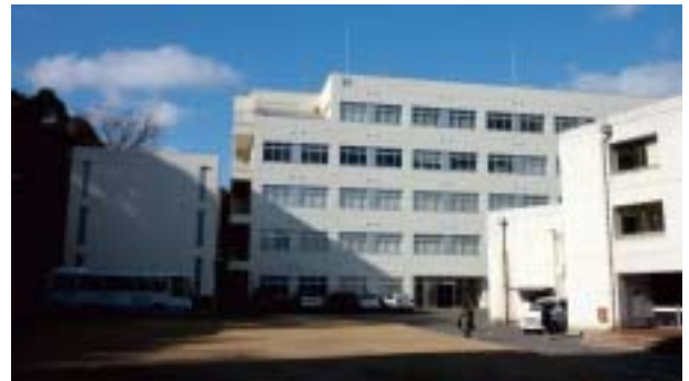
写真1 27号館と構造実験棟(左側の建物)
