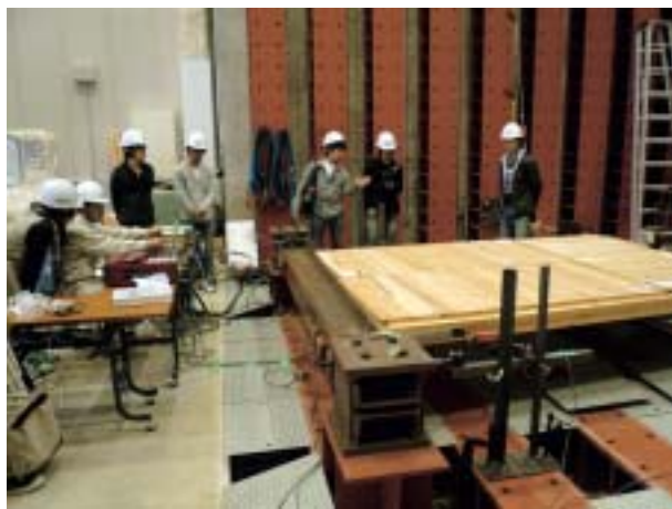
写真5 集成材による床組構法のせん断加力実験
