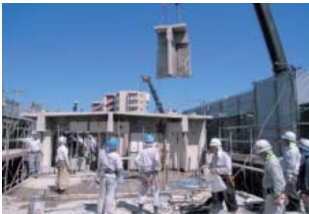
図9 減築中の施工現場(28号棟)
