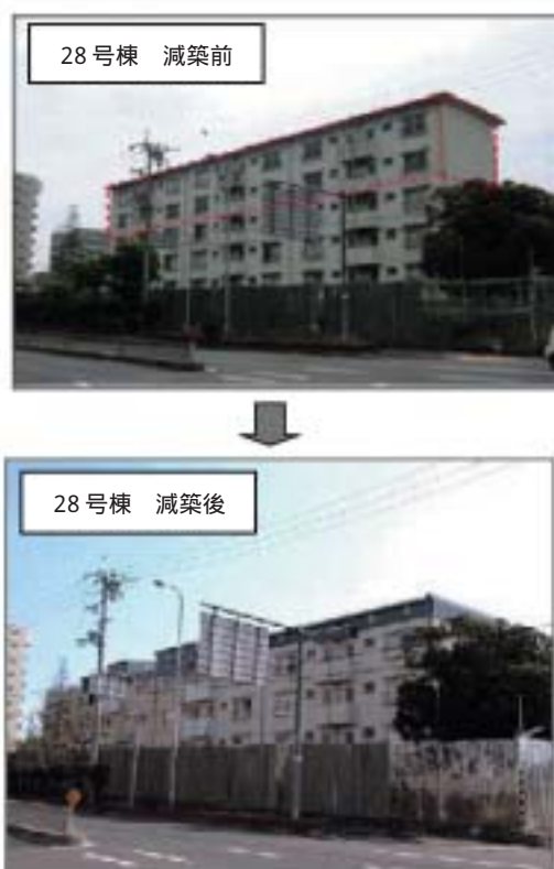
図11 上部2層減築による外観の変化
