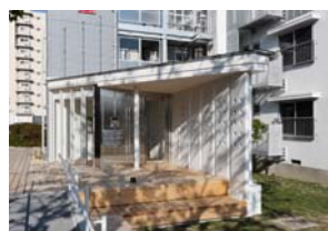
図5 27号棟エントランス
