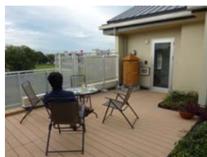
図8 26号棟4階ルーフトラス
