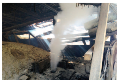
窯上部の排気孔出口
