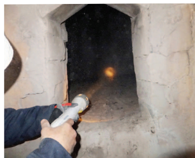
排気孔の位置を懐中電灯で示す
