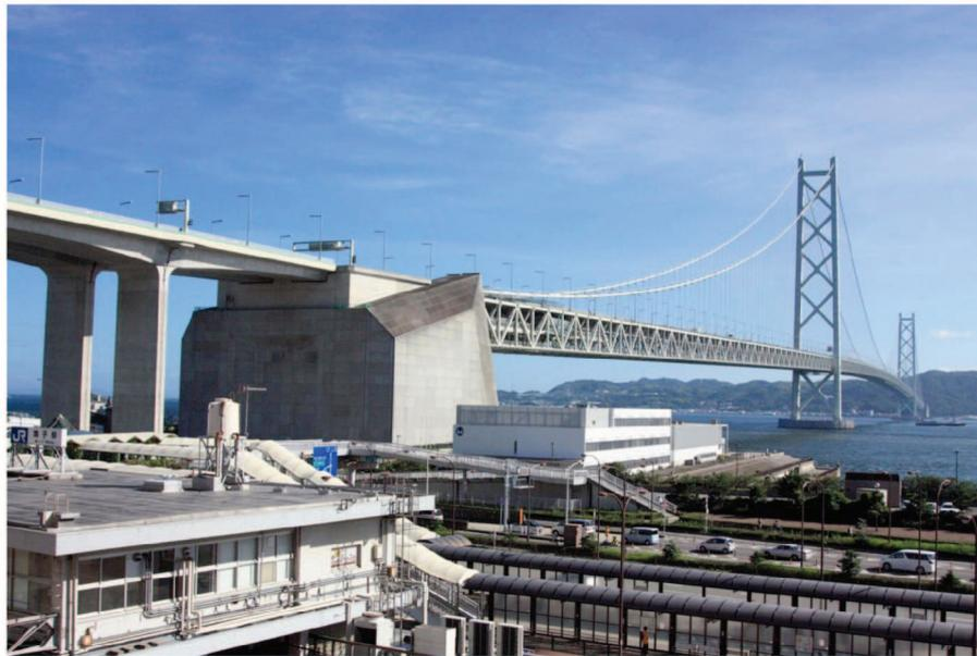
図7 高性能AE減水剤を使用した最初のビッグプロジェクト明石海峡大橋
