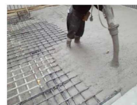
写真－3 打設状況
