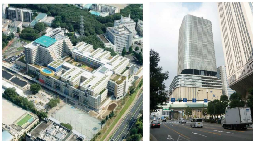
図2 大規模な水蓄熱システムを持つ総合医療センターと高層オフィスビル
