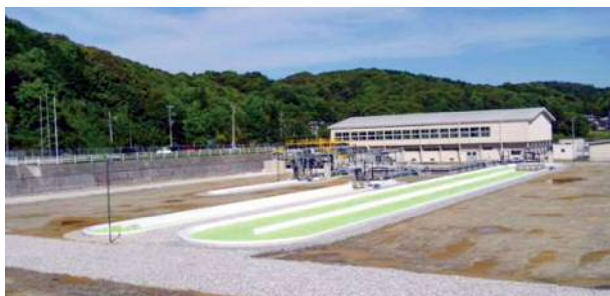
図6. 熊本県天草市に建設した実証プラント
