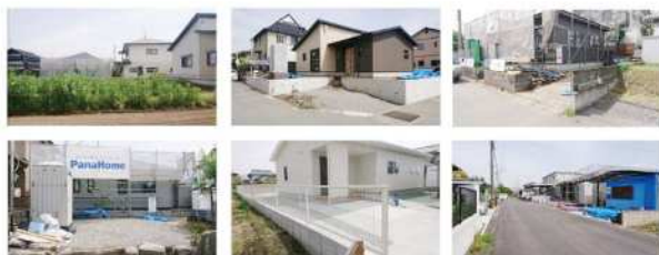
熊本地震復旧調査 2018年4月16日、17日
