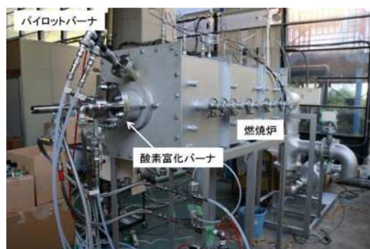
図 3 アンモニア燃焼炉
