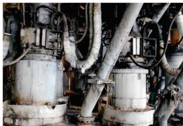
図 2 黄リン製造のための電気抵抗溶融炉 (中国開磷市)
