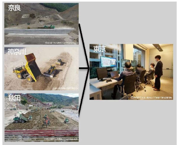
図-10 遠隔集中管制システムの実証状況
