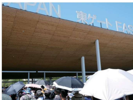
入場ゲート 軒裏の杉板は突合わせて張ってある
