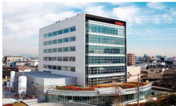
図7 岩谷水素技術研究所の外観 (当社中央研究所と併設)
