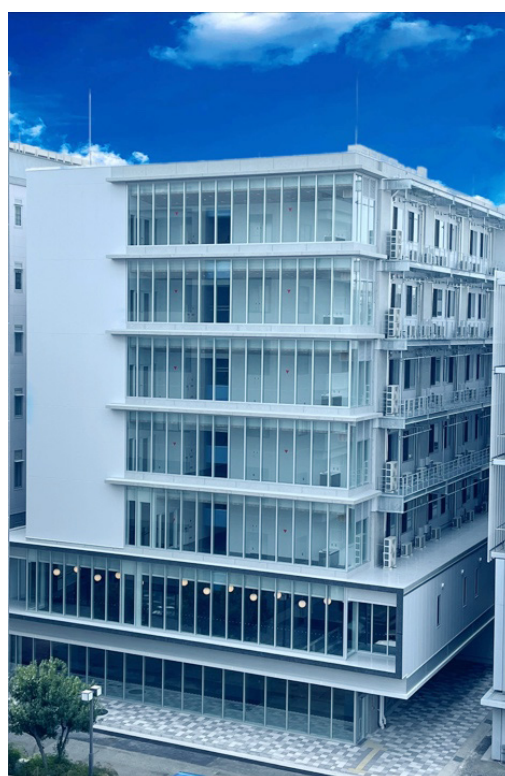
豊中共創棟Bの外観
