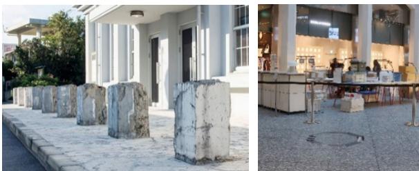
③与那原駅のRC柱の基部が残されている(与那原町立軽便与那原駅舎サイト*より) ④KITTE丸の内の床に印された旧東京中央郵便局の柱跡 * https://www.yonabaruekisha.com [③以外は筆者撮影]
