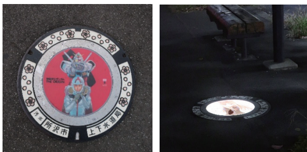
図6 所沢市下水道局のイルミネーションマンホール
